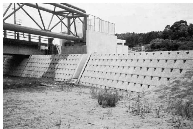
水管橋工事／熊川
