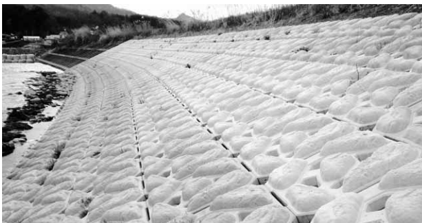
河川災害復旧工事（高瀬川）
